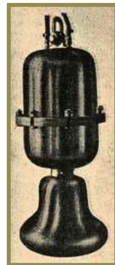
Figura 2 – Campana azionata dall'aria compressa , che si applica ai battelli.
