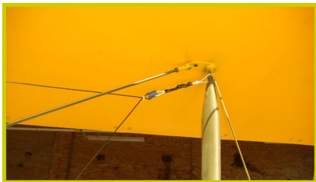
Fig. 22 secondo isolatore collegato completamente alla destra dell'ala superiore.
