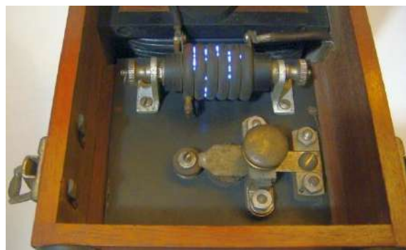
Foto N° 8 scaricatore a 6 dischi tutti collegati
